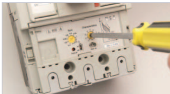
Selectarea unei caracteristici pentru Etibreak2 400A cu protecție electronică
